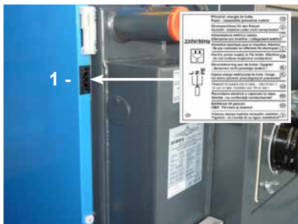
Разъем капотом справа котла
